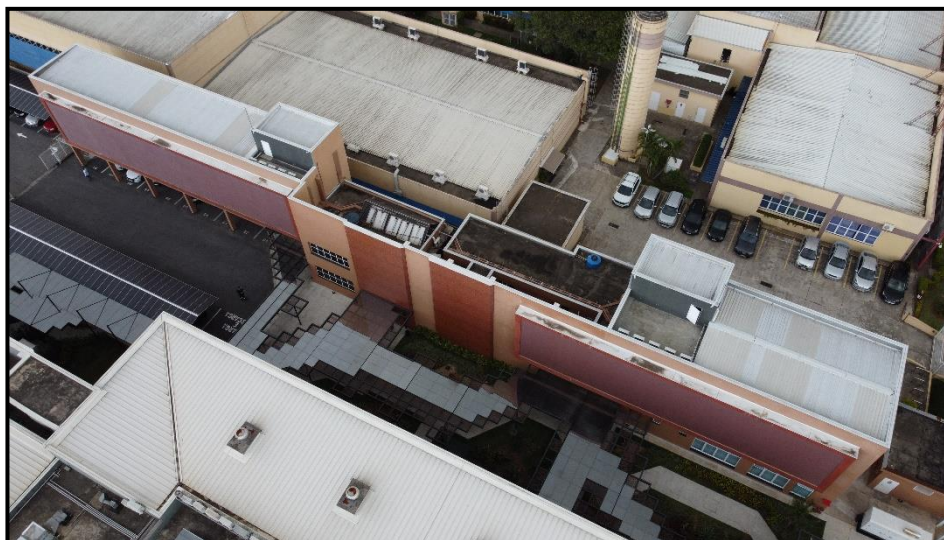
IMAGEM 24 – EDIFICAÇÕES DENOMINADAS – PRÉDIO ANEXO.
