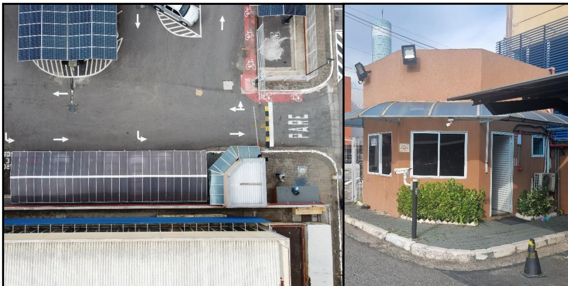
FIG. 26 - GUARITA EM AREA PROTEGIDA – RECOMENDA-SE A INSTALAÇÃO DO SISTEMA.
