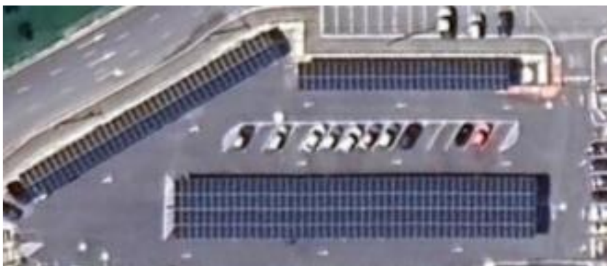
FIG. 27 – COBERTURA METÁLICAS FOTOVOLTAICAS – RECOMENDA-SE E EQUIPOTENCIALIZAÇÃO.
