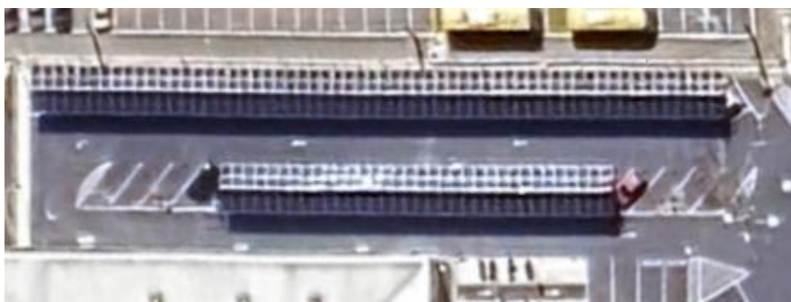
FIG. 28 – COBERTURA METÁLICAS FOTOVOLTAICAS – RECOMENDA-SE E EQUIPOTENCIALIZAÇÃO.
