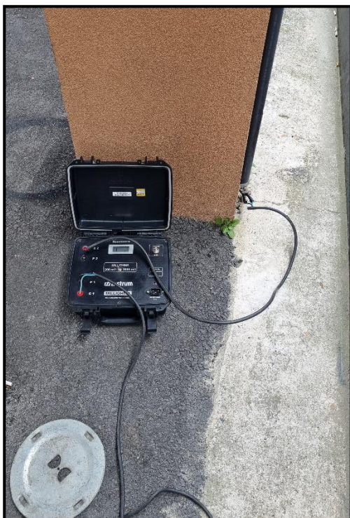
FIG. 27 – MEDIÇÃO DESCIDA, ATERRAMENTO E BEP
