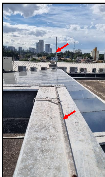
FIG. 3 – FITA ALUMÍNIO E MINICAPTOR
