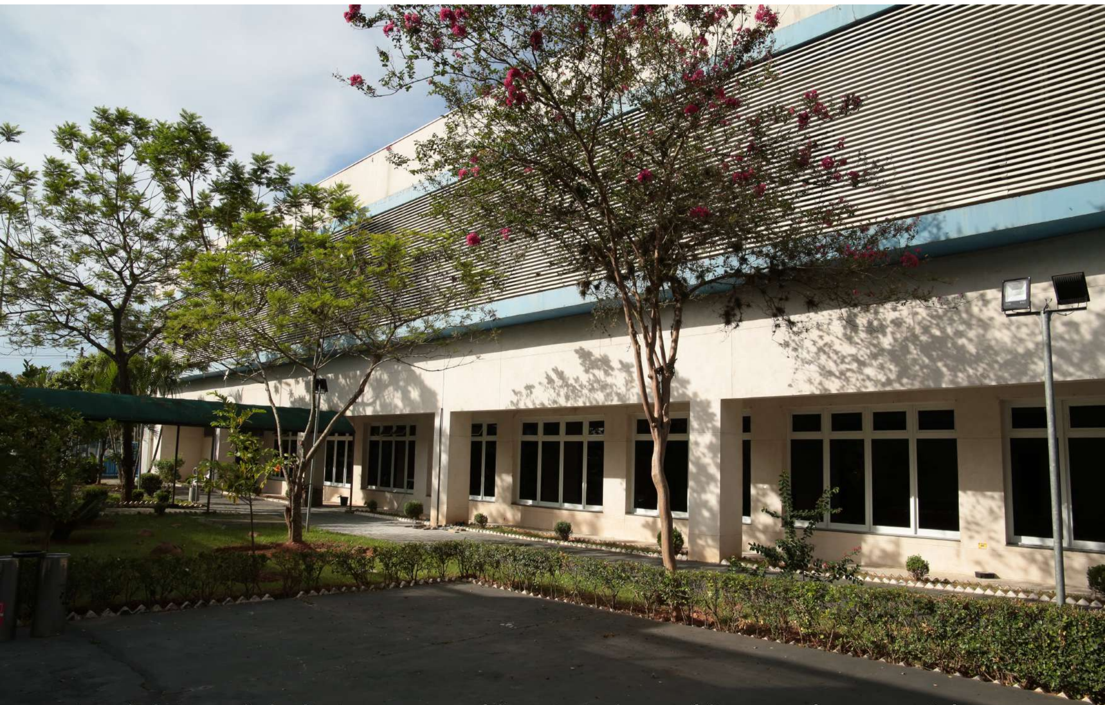
08 Vista do brise ao lado direito entre o prédio principal e o prédio anexo (manutenção)
