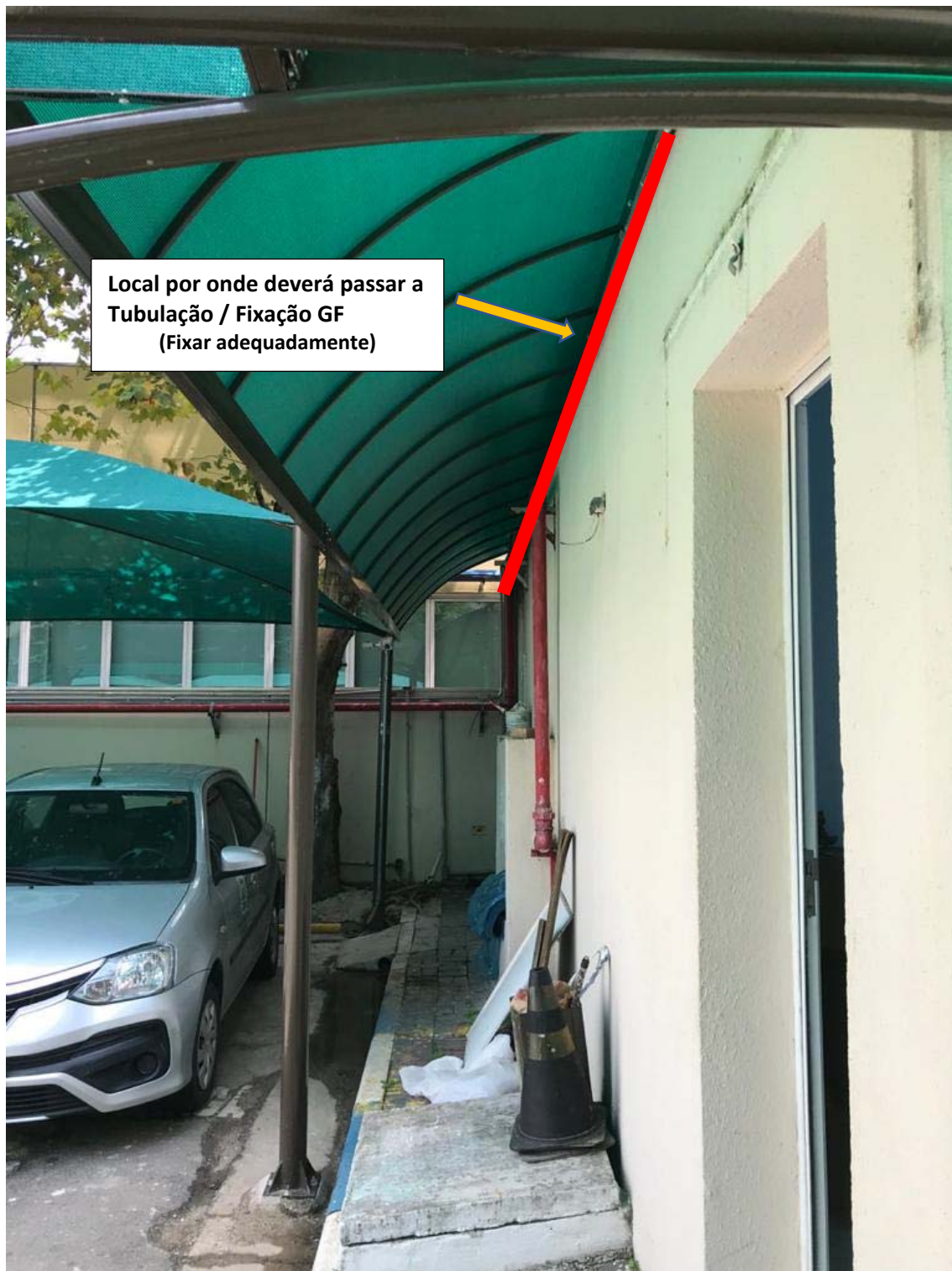
COBERTURA EXTERNA POR ONDE PASSARÁ A INFRA METÁLICA (A TUBULAÇÃO METÁLICA DEVERÁ SER FIXADA SOB A COBERTURA)
