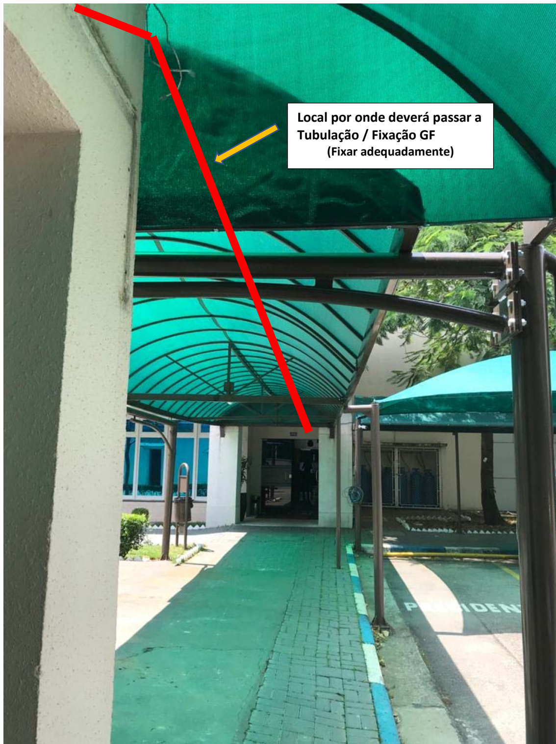
COBERTURA EXTERNA POR ONDE PASSARÁ A INFRA METÁLICA (A TUBULAÇÃO METÁLICA DEVERÁ SER FIXADA SOB A COBERTURA)
