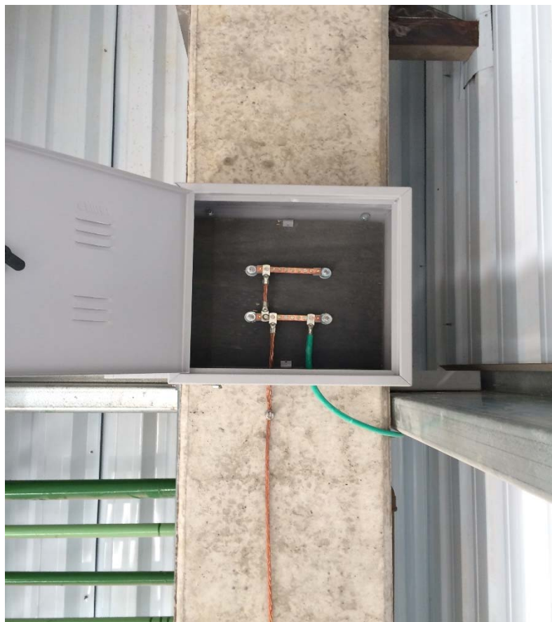
Figura 67 – LEP (Ligação equipotencial)
