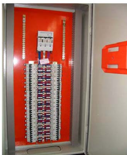
Figura 47 – quadros elétricos de embutir
